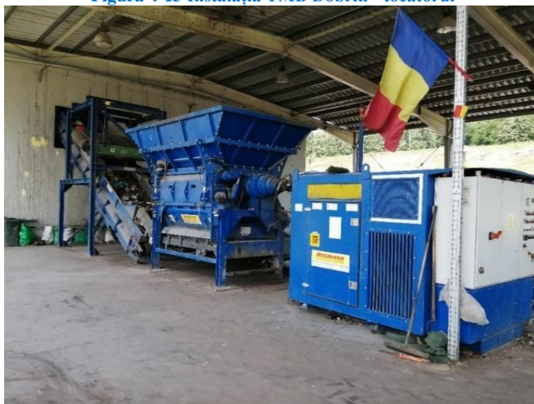
Figura 4-13 Instalația TMB Dobrin - tocătorul
