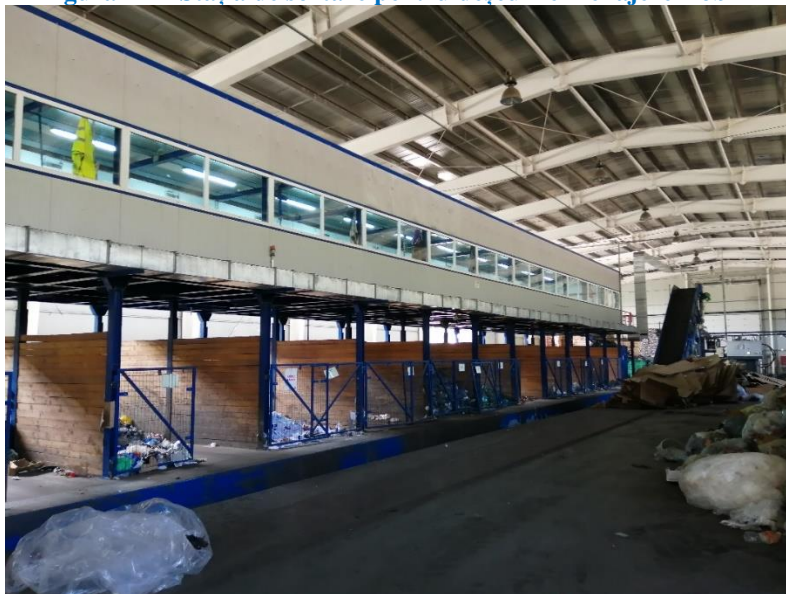
Figura 4-12 Stația de sortare pentru deșeurile menajere Dobrin
