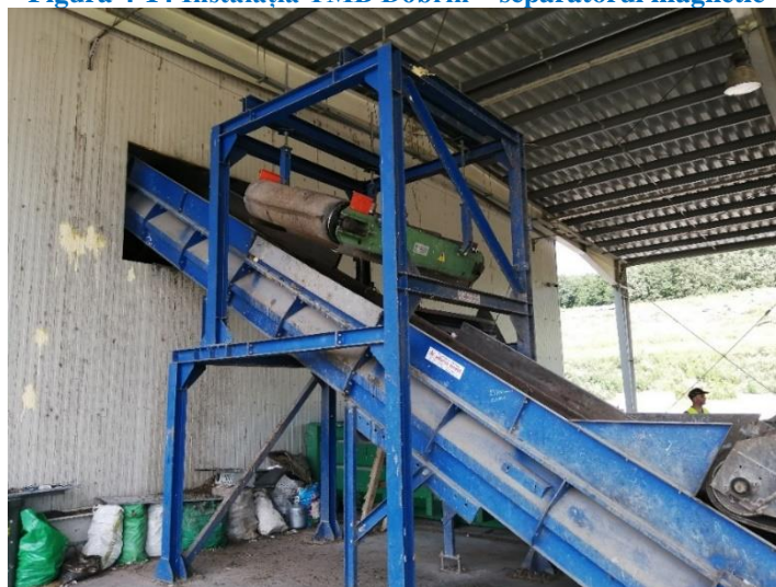
Figura 4-14 Instalația TMB Dobrin – separatorul magnetic
